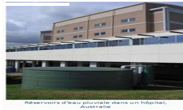
Figure 12 : Systèmes de collecte des eaux pluviales
